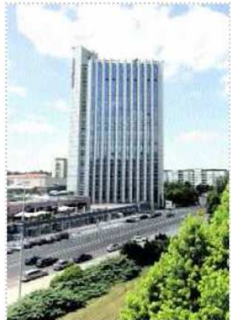
Das Hotel Mercure ist eine Feuerfalle, stellte ein Gutachter im Auftrag des MDR fest. Geschlossen wird es trotzdem nicht. Foto: Patzig
